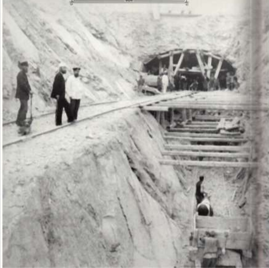
Строительство туннеля в Верхнебаканке
