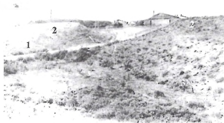
24. Прорез Азовских ворот Фанагорийской крепости. Экспликация: 1. Дорога через ров. 2. Вал крепости. 3. Оборонительный ров
